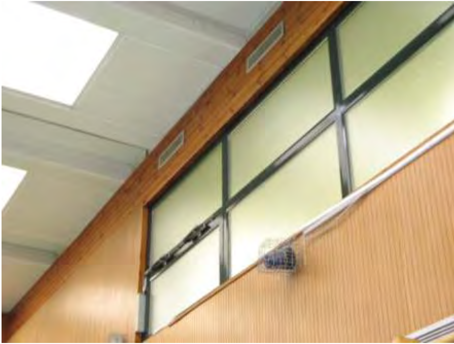
Arbeitsraum ist ein Turnsaal
