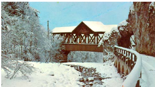
Die Brücke am Eingang zur Klamm ist bereits neu saniert
